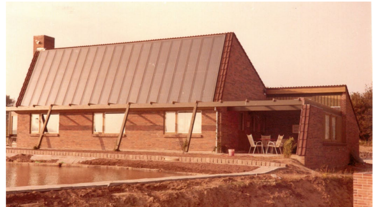
Solenergi-paneler installeret på Jean Fischers "Plusenergi"-hus, Tommerup, 1982
