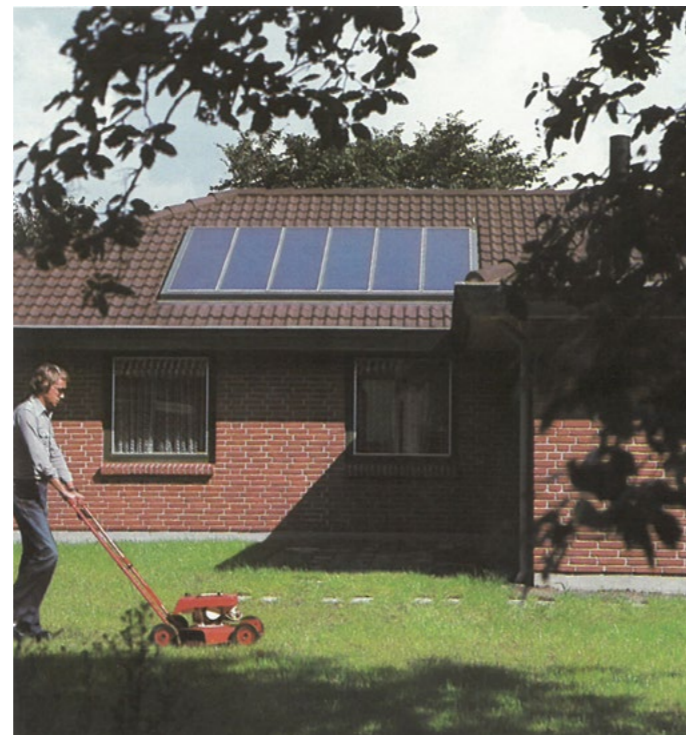
Dæmpa solvarmepaneller monteret på privat bolig
