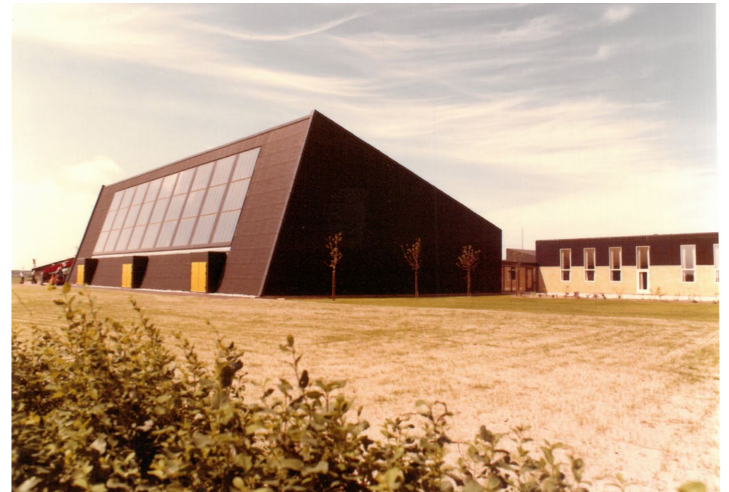
Solceller monteret på Nymarksskolen, Kerteminde
