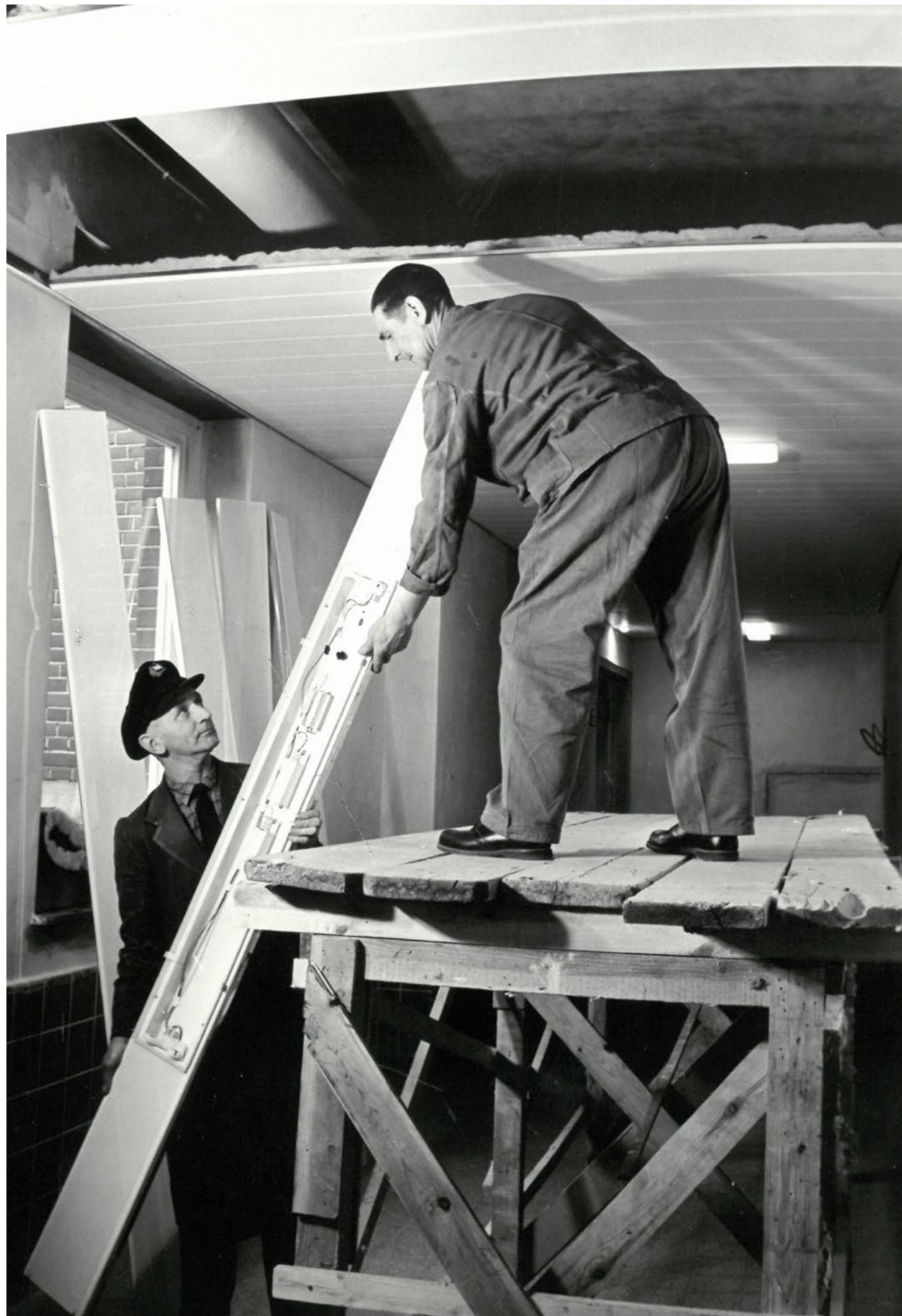
Installation af Dæmpa loftpaneler, cirka 1965
